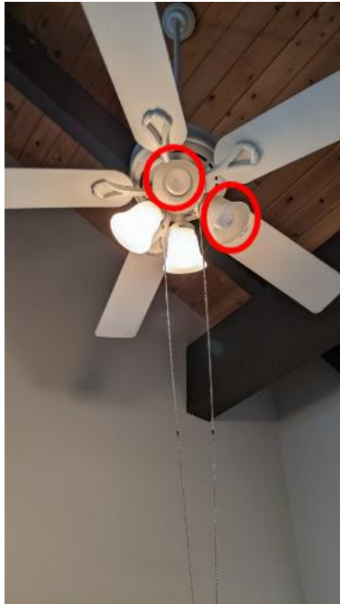
Ceiling fan bulbs out
